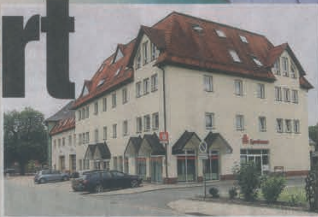
◀ In diesem Haus in Zwickau kaufte Gottfried M. eine Dachgeschosswohnung für 90 000 Euro (3 Zimmer, 55 qm), die nur 18 000 Euro wert war
